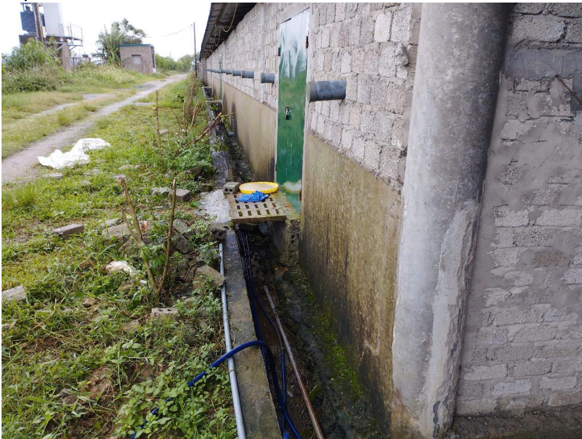
Hình 3. 1. Rãnh thoát nước mưa chảy tràn
